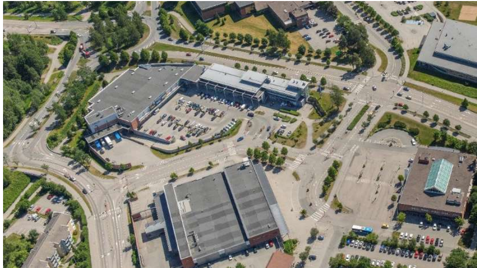
Kuva 2 Suunnittelualueen viistoilmakuva tilanteesta ennen uuden linja-autoaseman toteuttamista
